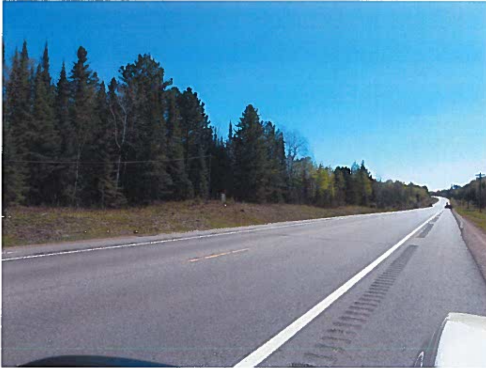
CSAH 110/Bridge 488 Looking East
