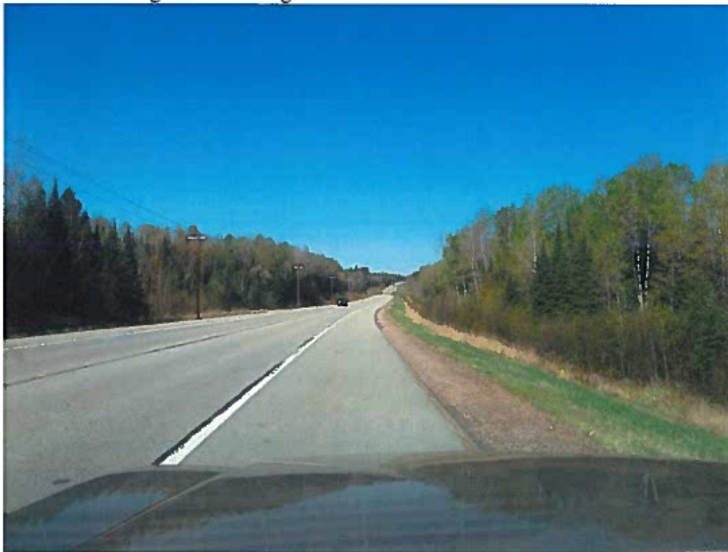
CSAH 110/Bridge 488 looking West
